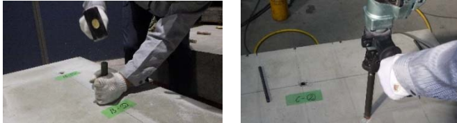
人力施工 (ハンマー重量 1.5kg) 機械施工 (ハンマードリル DH-38)
